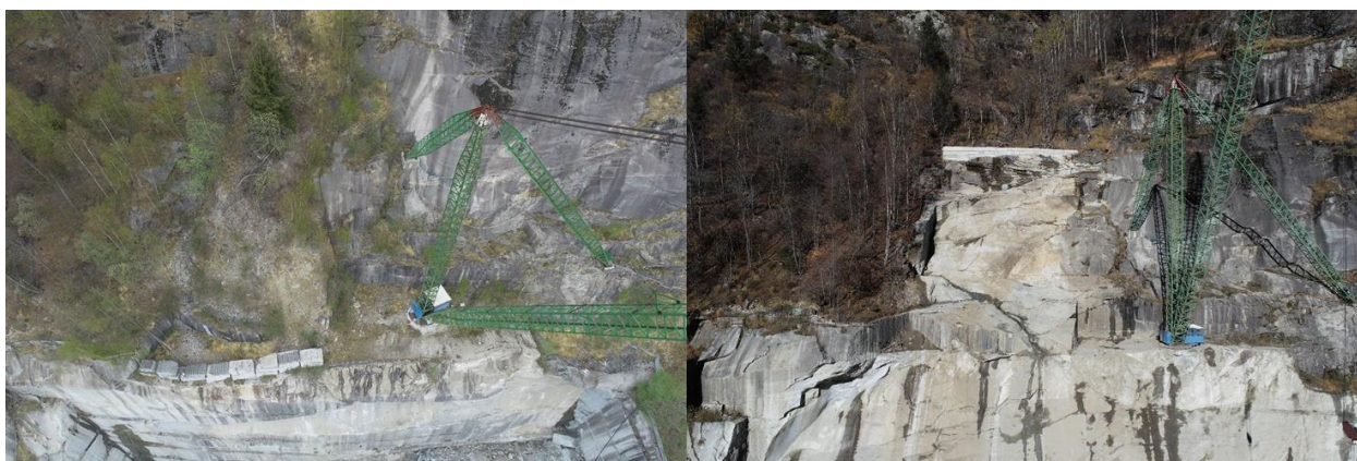
Figura 4: A sinistra, ripresa sommitale da drone in data 21 aprile 2022, dopo il primo evento di crollo con barriera in blocchi sul gradone sommitale. A destra, ripresa frontale da drone in data 21 novembre 2022, al termine della scopertura dell'ammasso roccioso con il muro che agisce da presidio di sicurezza per le attività sottostanti in posizione sommitale, stabile ed estranea alla porzione di ammasso fratturato sottostante. (Fonte: Istanza di Accertamento di Compatibilità Paesaggistica del Marzo 2023).
